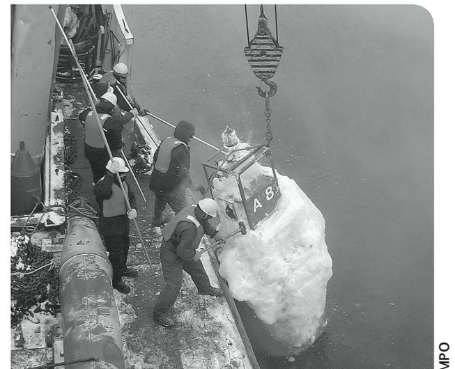
L'équipage du NGCC *Tracy* doit déglacer les anneaux de levage de cette bouée d'été lumineuse avant de la hisser à bord. Elle sera remplacée par l'espars d'hiver (sur le pont).
